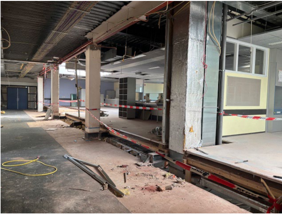
Gang science-floor volledig gesloopt
