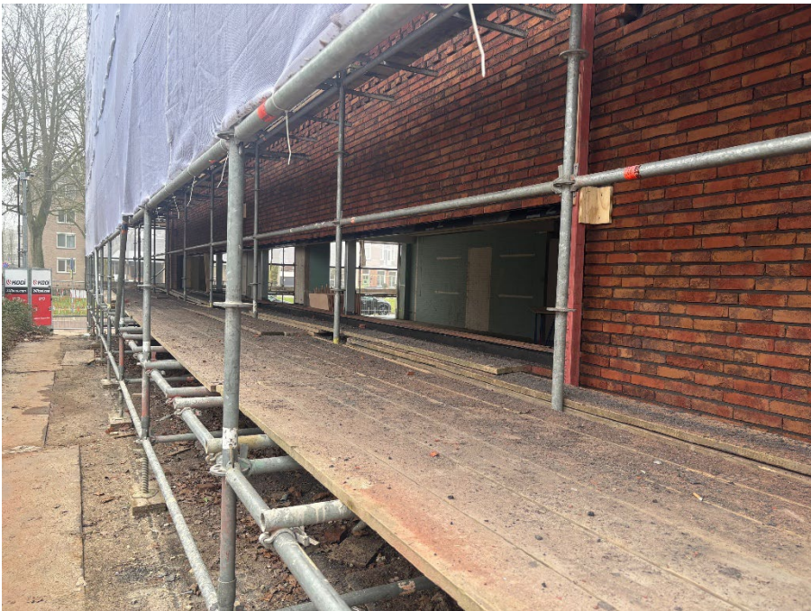
Sparing ten behoeve van raampartij kopgevel buitenzijde
