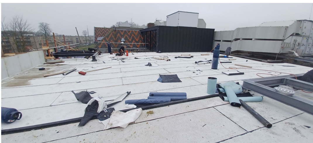
Dak weer waterdicht
