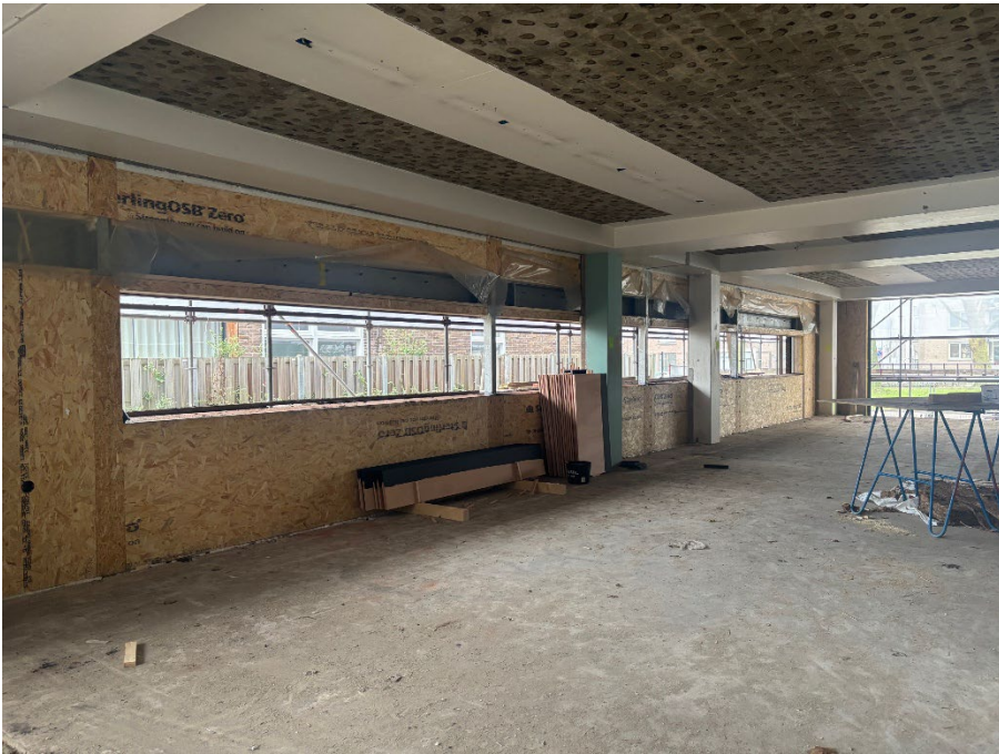
Sparing ten behoeve van raampartij kopgevel binnenzijde
